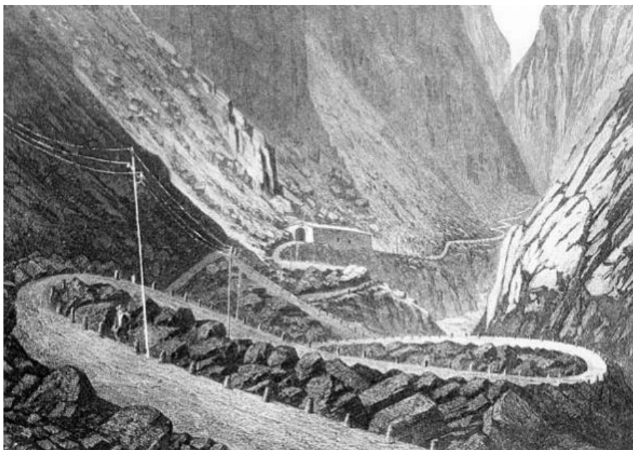
Gotthardstrasse und Telegrafanlage in der Schöllenschlucht um 1860. Museum für Kommunikation, K niz/Bern.
