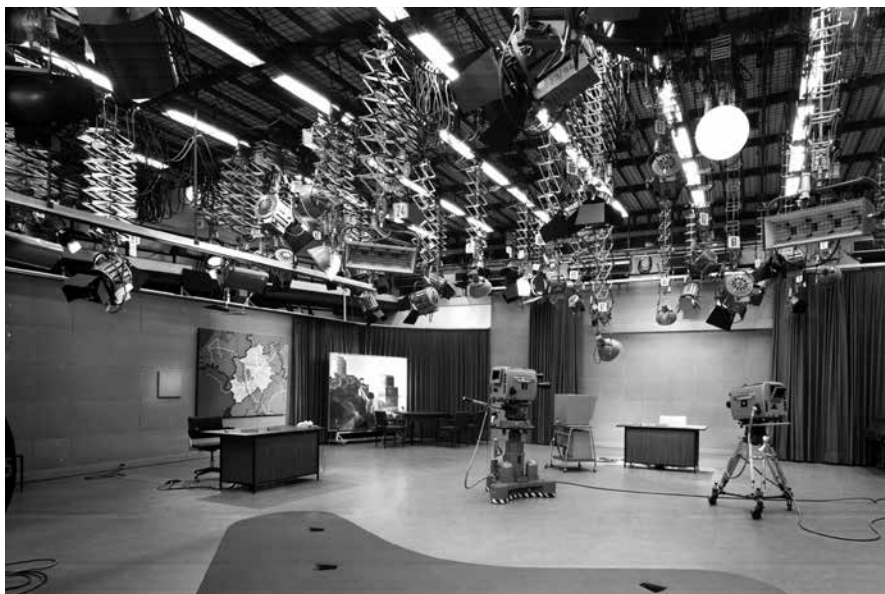
Das Studio C im 1966 eröffneten Erweiterungsbau des WDR: lichte Bauhöhe, tief im Kölner Boden, hoch unter der Decke viel Technik (Historisches Archiv des WDR).
