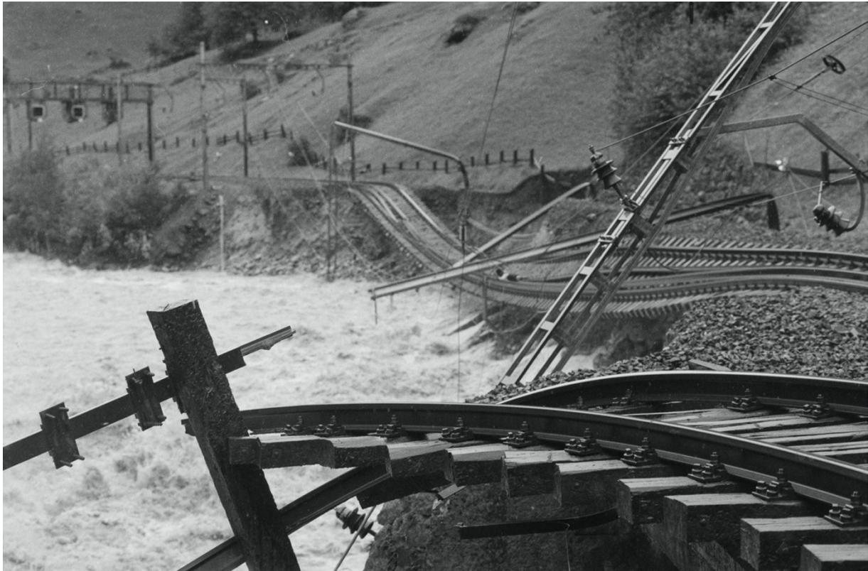
Abb. 9: Weggespülte Doppelspur der SBB-Gotthardlinie in der Nähe von Gurtnellen (Uri) (Quelle: Enz, «Unwetter Uri», 25.08.1987, ETHZ e-pics Com\_L36-0227-0001-0006.)
